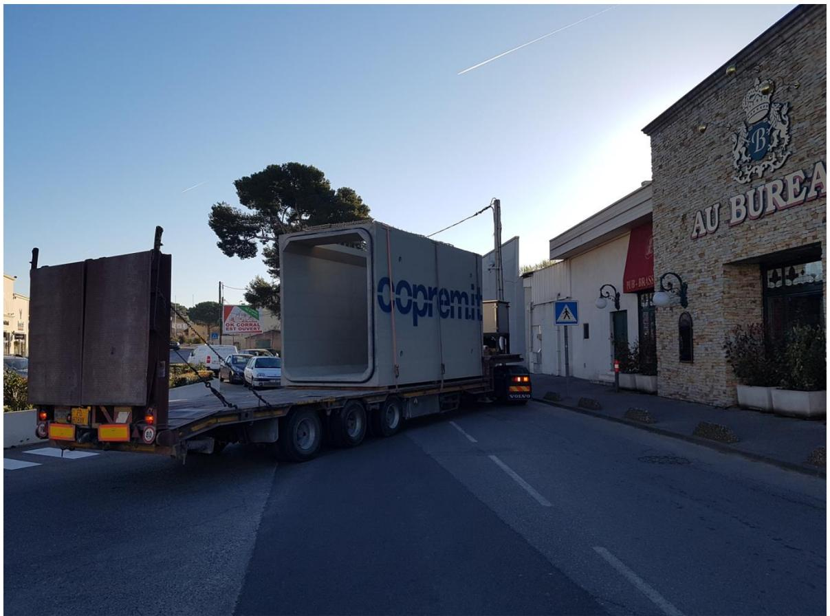
La pièce spéciale de connexion du réseau au collecteur avec emboîtement
