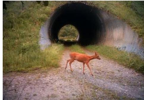
**Coprem**, en partenariat avec **S-T**, a proposé un ouvrage de 45ml en tuyau de fonçage de diamètre nominal 1400 dimensionné sous 5,40m de remblais sous autoroute, en béton résistant aux agents chimiquement agressifs et à la corrosion par carbonatation.
